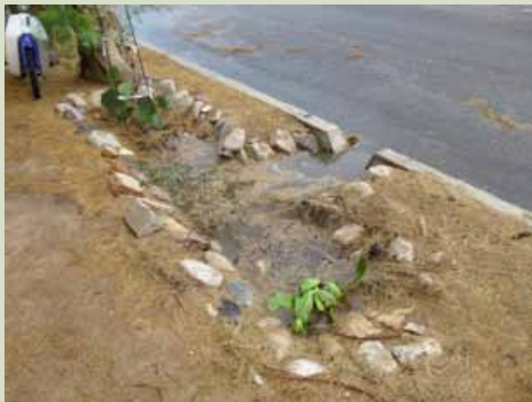
Figura 5. Dibujo conceptual de un corte en la guarnición y zanja con bordes poco inclinados en el DDV.
