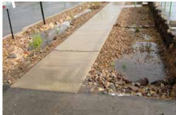
Abril 2009: las zanjas recién excavadas concentran el flujo para alimentar a las plantas jóvenes.
