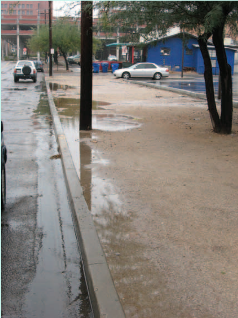
Antes: En este Derecho de Vía de la ciudad de Tucson, los pequeños cortes en la guarnición permitieron que el agua fluyera hacia las zanjas, a árboles recién sembrados, y después hacia la calle.
