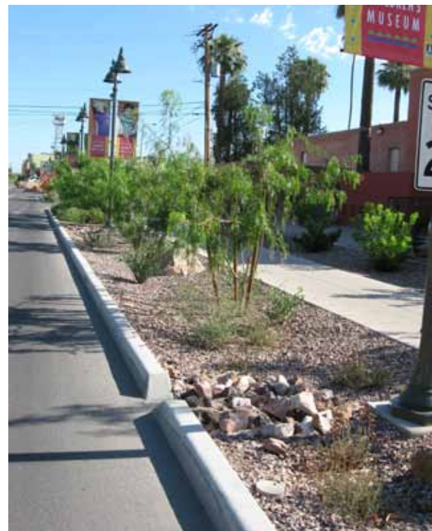
Esta depresión larga y poco profunda en el derecho de vía tiene numerosos cortes en toda su extensión
