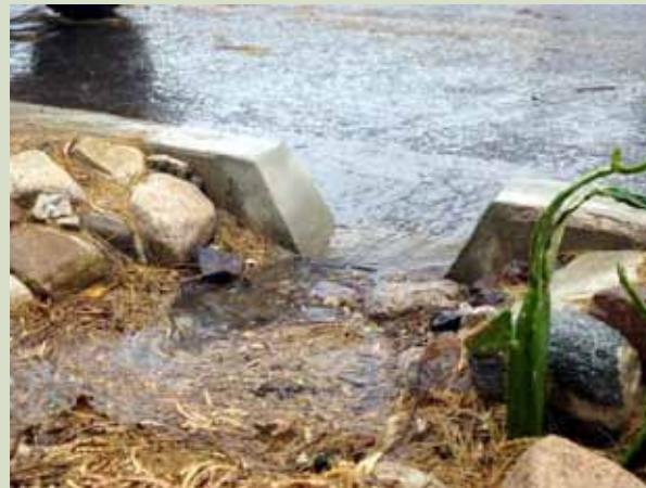
Figura 5. Dibujo conceptual de un corte en la guarnición y zanja con bordes poco inclinados en el DDV.
